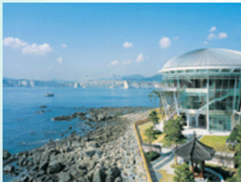
Nurimaru APEC House
